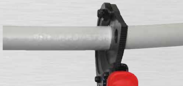
Bild 2: Ablängen der Leitung
