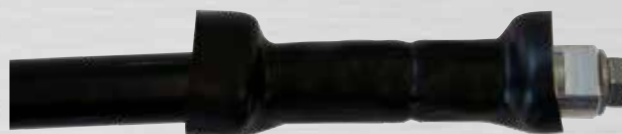
Bild 46: Beginn Schrumpfprozess
