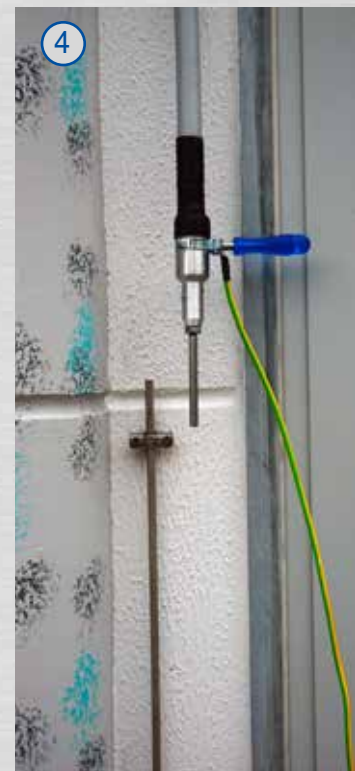
④ Trennklemme (z.B. Vario-Klemme) öffnen und entfernen (trocken und sauber lagern).
