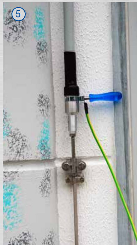
⑤ Mit Trennklemme (z.B. Vario-Klemme) den Anschlussbolzen des Fußstückes mit der Erdungsfahne verbinden.
