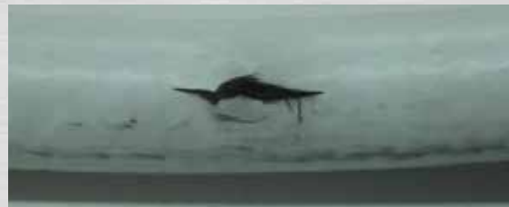
Stark aufgeplatzter Mantel
