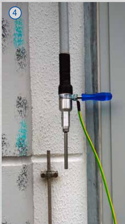
④ Zylinderkopfschrauben mittels Drehmomentschlüssel (Best.-Nr. 600 540) mit 6 Nm festziehen.
