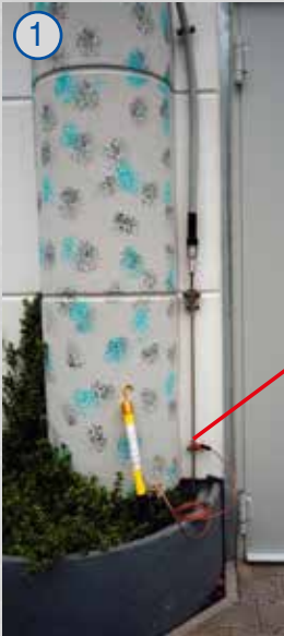
① Erdungsstab mit Erdungsfahne verbinden.
