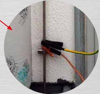
② Potentialausgleichsbrücke mit Erdungsfahne und Oberteil des Fußstückes verbinden (direkt unter Schrumpfschlauch).
