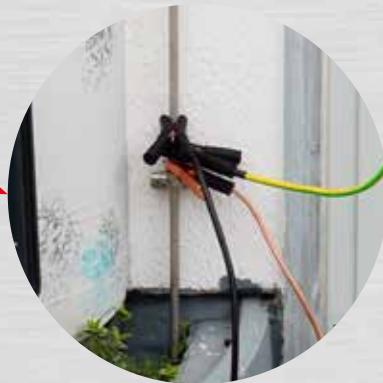
③ Funktionserdungsanschluss von Messgerät mit Erdungsfahne verbinden.
