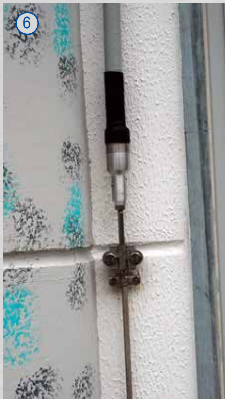
⑥ Potentialausgleichsbrücke abziehen.
